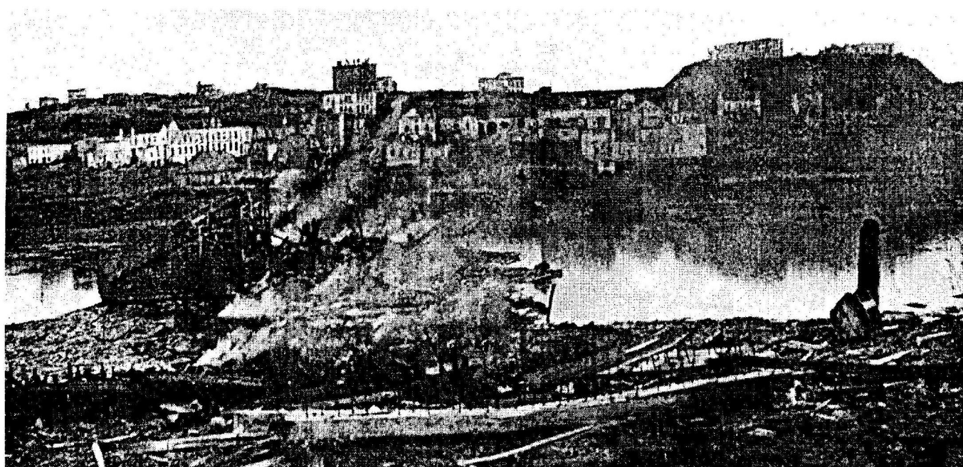
Дорогобуж. Сентябрь 1943 г. Горит мост через Днепр
