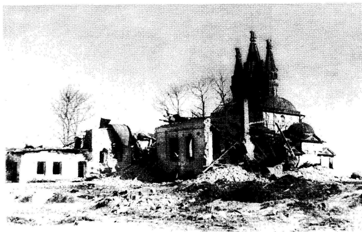
Город Вязьма. Разрушенная церковь
