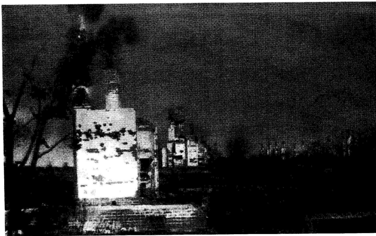
Вид разрушенного города Ярцево. Одна из улиц
