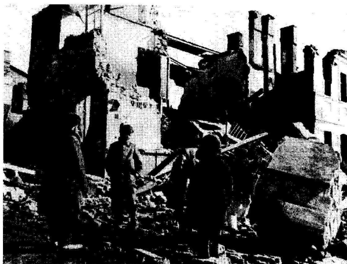
Разрушенная фашистами школа. Автор снимка Лазебник Н. Я.
